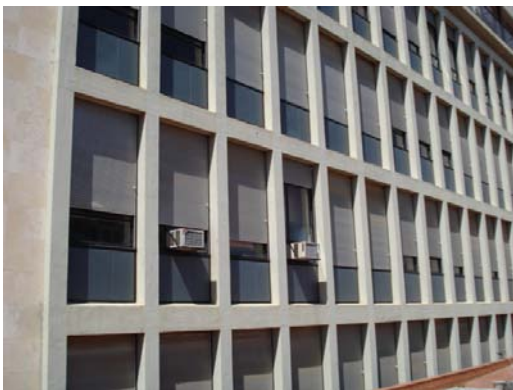
Vista exterior finestres façana C
