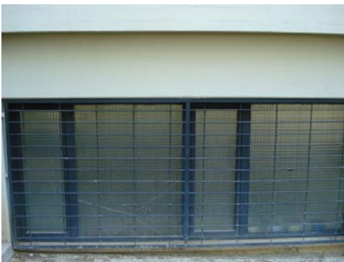
Detall finestra T4, façana A, vista exterior
