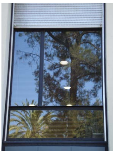
Detall finestra T1 des de l'exterior (Façana A)
