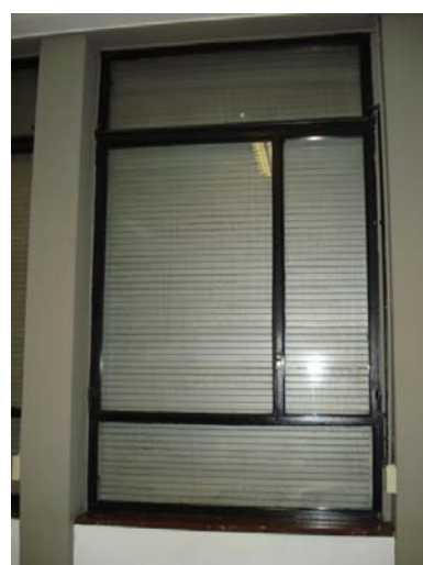
Detall finestra T1 des de l'interior
