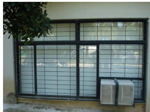
Detall finestres T5, façana A, vista exterior
