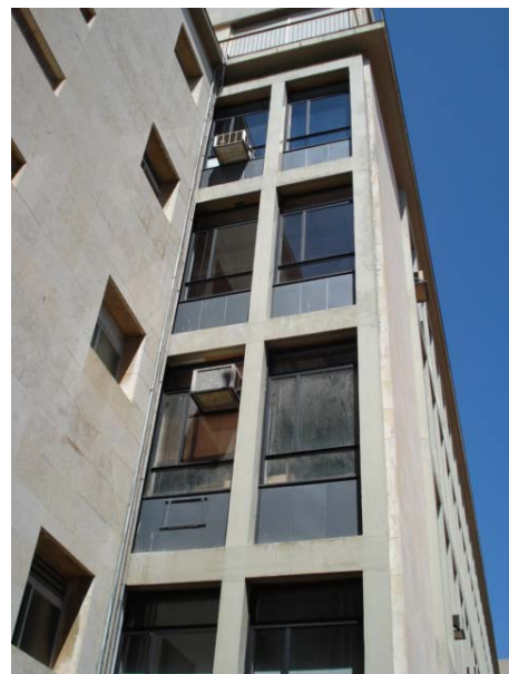
Vista exterior finestres façana D
