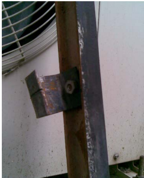
Ancoratge del bastiment a l'obra.
