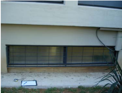
Detall finestres T2, façana A, vista exterior
