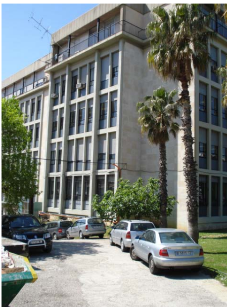
Vista exterior finestres façana C
