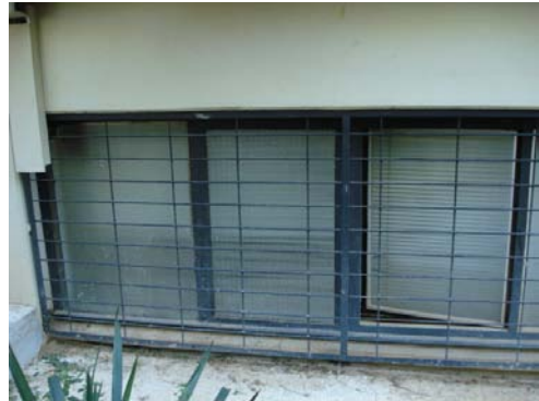
Detall finestres T3, façana A, vista exterior
