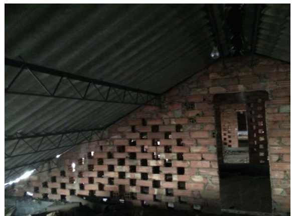
Fotografia de la sotacoberta de la nau.
